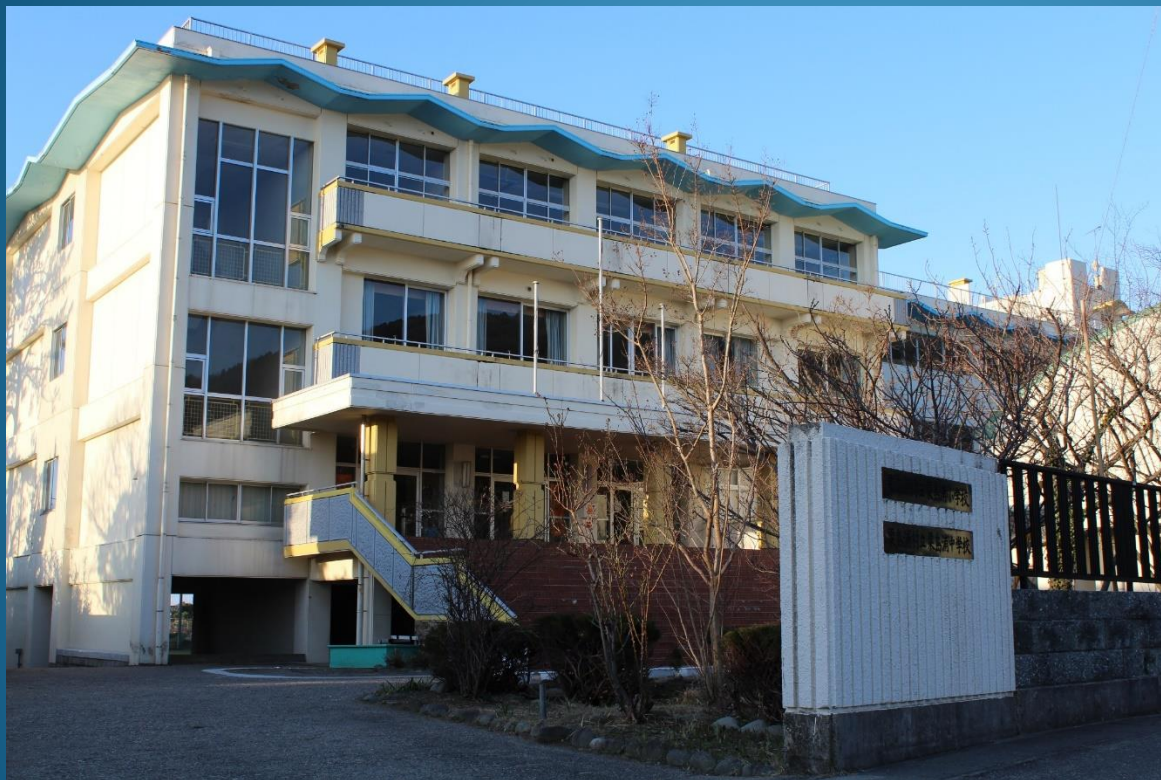
校舎(3階:小学校、4階:中学校)
