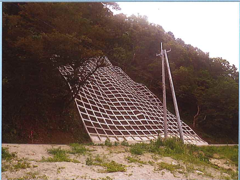
復旧完了 (令和元年10月)
