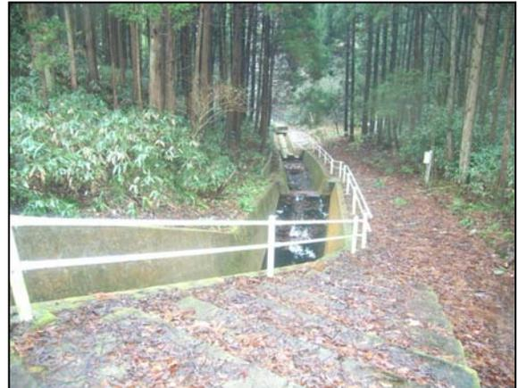
三面コンクリート張り水路と最下流のRC造り取水柵×1池により表流水を取水
